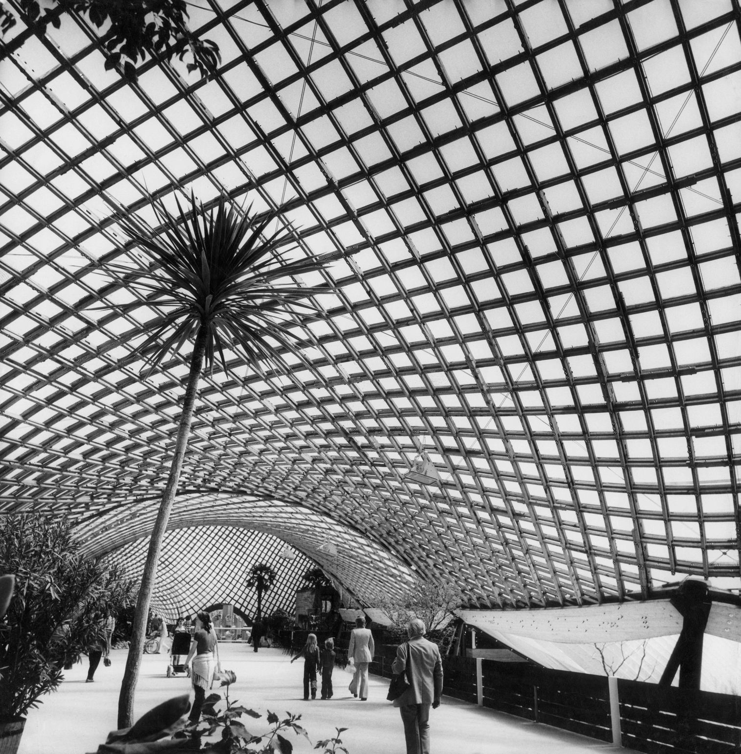
Multihalle Mannheim 1978 ©RobertHäusser
